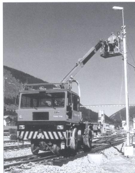
GSM 8003 bei Fahrleitungsmontage auf der Zufahrtsstrecke zum Zwischenangriff in Sedrun (Las Rueras, 25.8.98; Foto F+F; J.Blaser)
